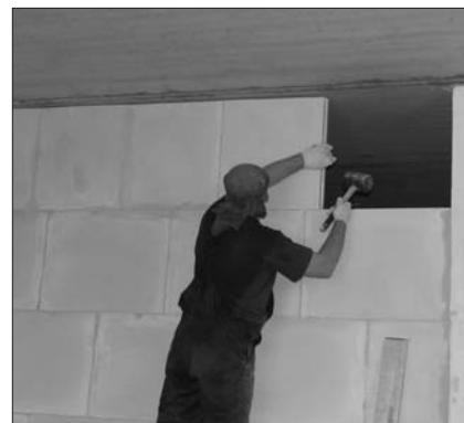
Рис. 5. Монтаж перегородки из пазогребневых блоков: 1 – начало монтажа; 2 – окончание монтажа
