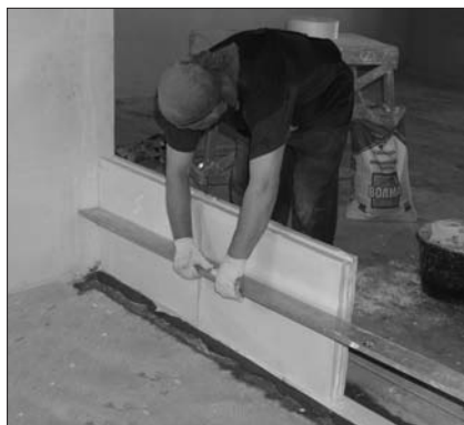
Рис. 5. Монтаж перегородки из пазогребневых блоков: 1 – начало монтажа; 2 – окончание монтажа
